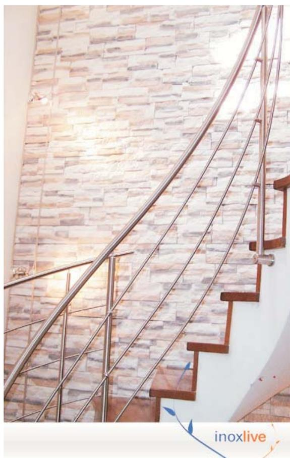
Montanti vengono realizzati utilizzando tubo inox Aisi 316 a sezione rotonda, Nel sistema di fissaggio laterale la base viene dimensionata in funzione della sporgenza di rivestimento mentre nella situazione di fissaggio su piano orizzontale la base permette l'appoggio su ogni tipo di rivestimento e l'assenza di viti a vista nascondendo il fissaggio all'interno di essa.
